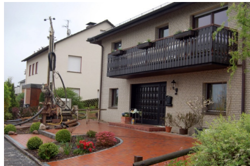
Bohrgerät zur Sondenbohrung für eine Sole | Wasser-Wärmepumpe im Einfamilienhaus
